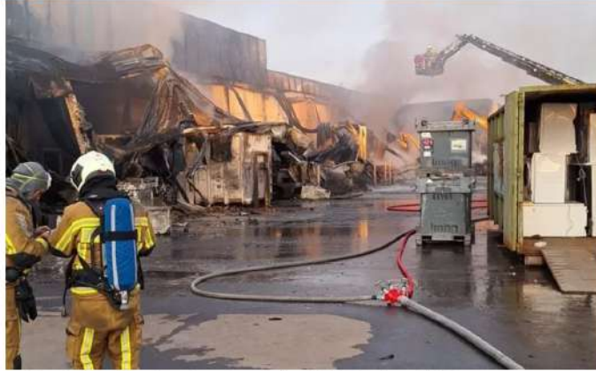
De schade was bijzonder groot, na de monsterbrand bij IMOG in Moen. © IMOG
