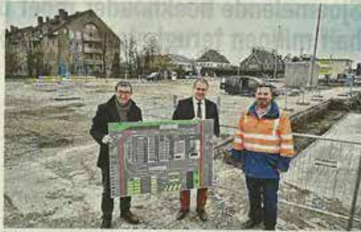
De werken aan het recyclagepark zijn al een tijdje bezig. © LOH
